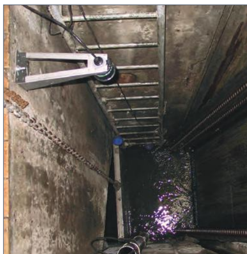
КОЛОДЕЦ 6 м С ЛЕСТНИЦЕЙ И ПОПЛАВКОМ
