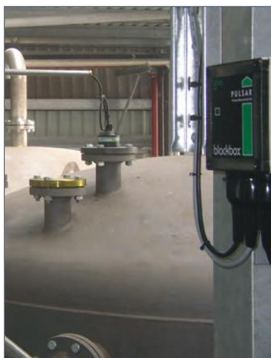
ДАТЧИКИ С ФЛАНЦЕВЫМ СОЕДИНЕНИЕМ НА РЕЗЕРВУАРАХ
