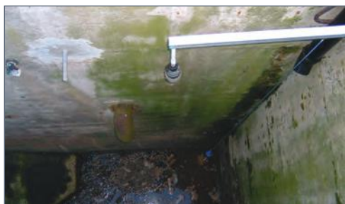
ШАРНИРНЫЙ КРОНШТЕЙН НАД ВОДОПРИЕМНЫМ КОЛОДЕЦЕМ
