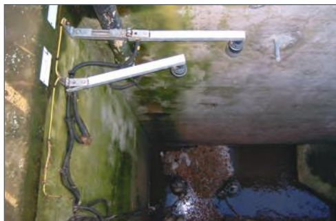
ШАРНИРНЫЙ КРОНШТЕЙН НАД ВОДОПРИЕМНЫМ КОЛОДЕЦЕМ
