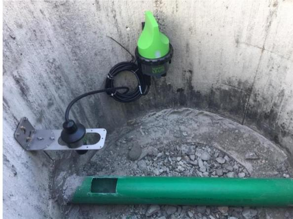
Рисунок 8 - Пример монтажа акустического преобразователя в колодце
